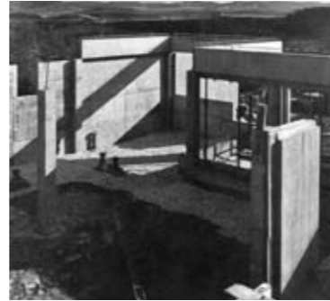
→7.17 Sammlung Domnick, Rohbau, April 1967
