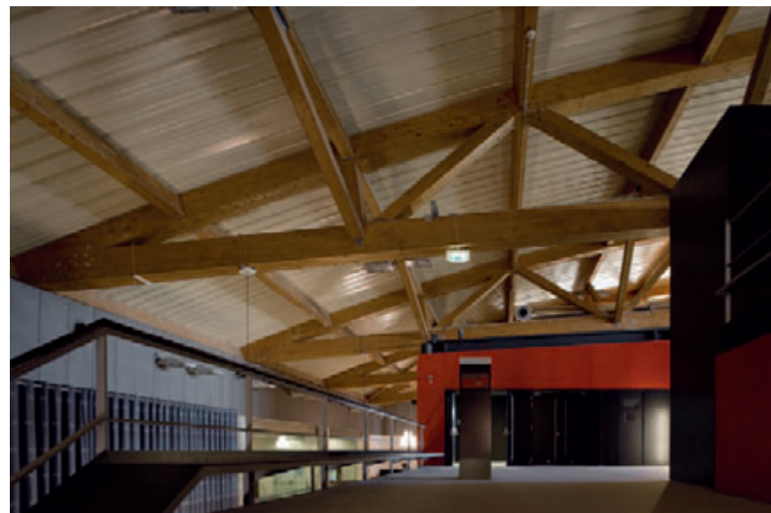
"Passos Perdidos" Lobby area
