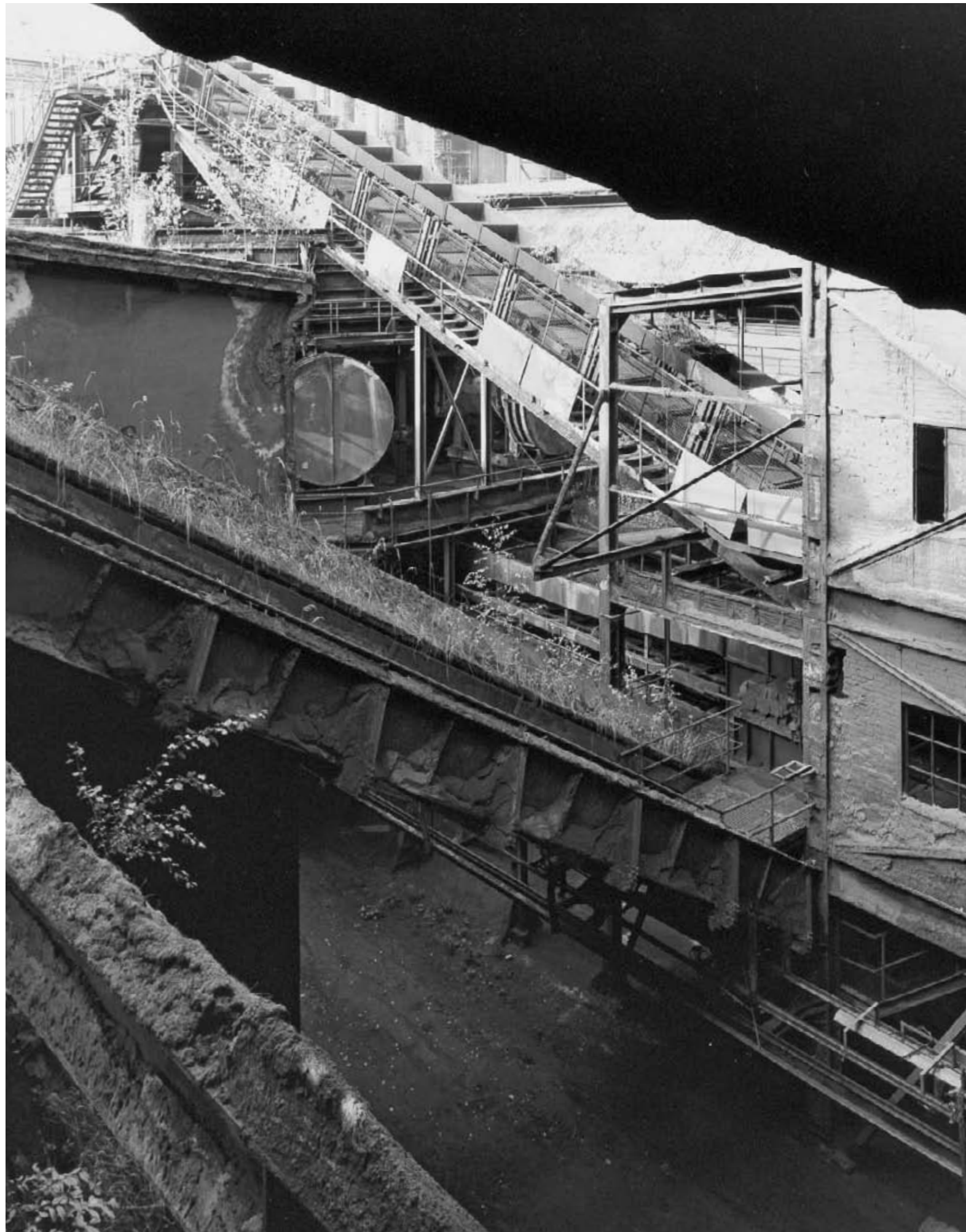
8, 9. Die verschiedenen Stationen der Erzaufbereitung sind auf engstem Raum untergebracht. Transportbänder, Leitungen und Stegbrücken stellen in einem komplizierten System die Verbindungen her.
