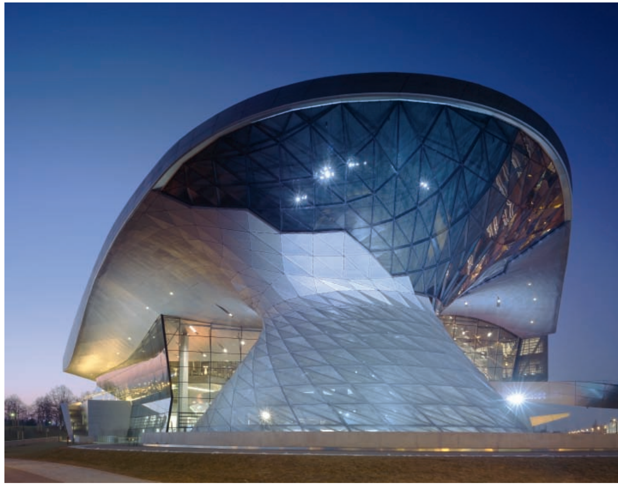
14. Gesamtansicht von Südosten. 15. Detailansicht von Osten. 16. Detailansicht von Nordosten.
