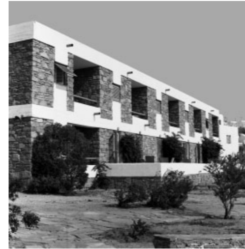
635. Xenia Hotel auf Mykonos, 1960. Architekt: Aris Konstantinidis. 636. Treppenweg an der Quelle von Kato Petali auf Siphnos.
